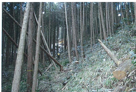
作業道施工前
