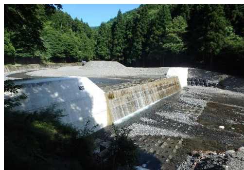
補修による機能回復
