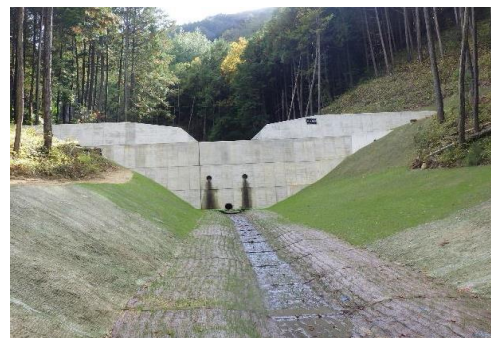
谷止工を設置
