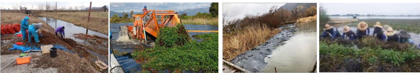
巡回・監視・駆除 機械による駆除 遮光シートの敷設 「淀川方式」による駆除
