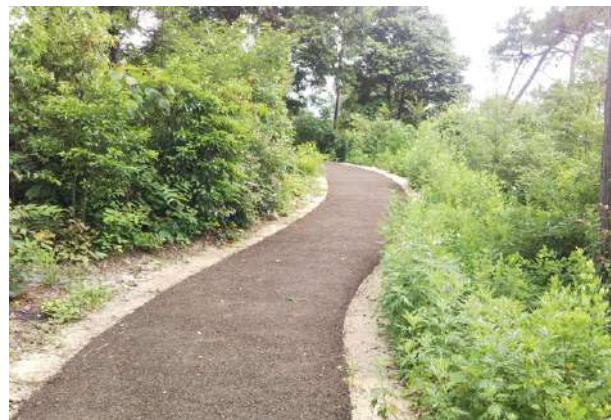
当製品は解体工事や間伐で発生した廃木材をチップ化し、加熱アスファルトと混合する舗装材です。従来木質舗装の課題であった耐久性を向上させ、10年以上の耐用年数、車両の乗り入れにも対応します。1000m<sup>2</sup>3cm厚の施工で、約17tのCO<sub>2</sub>を歩道空間に固定することができます（焼却処分との比較）。不要になった木質舗装材を剥がし、再生処理を行うことで再施工が可能です。
