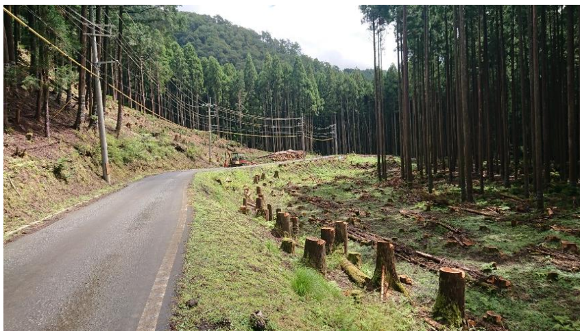
道路沿いの予防伐採を行った現場
