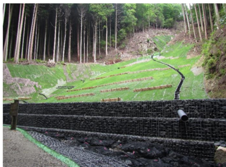
治山工事(木柵工・木筋工)
