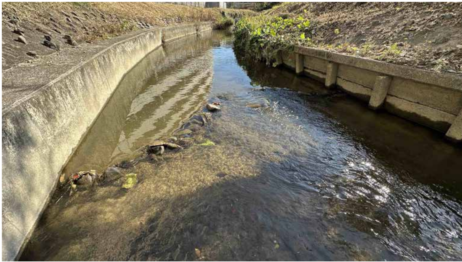
バープで流速の変化を付けてみる。後は小石を敷き詰める
