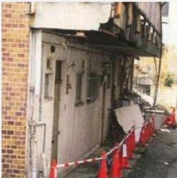
外壁剥落等の危険な状態
