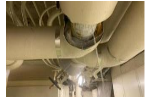
空調設備の配管が錆により欠損し水漏れが発生
