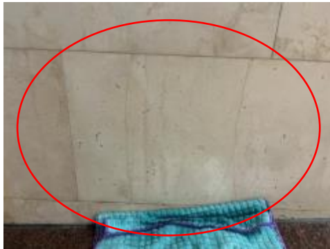
雨水が染み出した壁面
