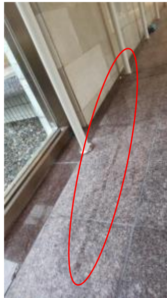
染み出した雨水が流れ込むエントランス
