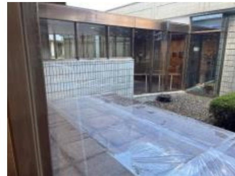
雨水侵入のためビニールで養生した回廊と外壁
