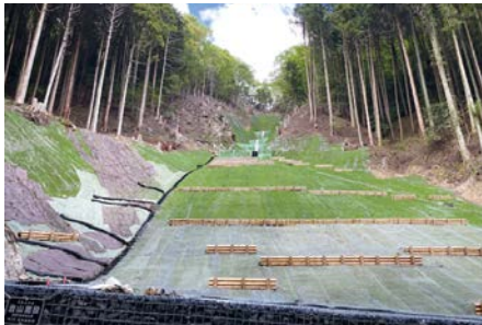
▲治山施設（山腹工）
