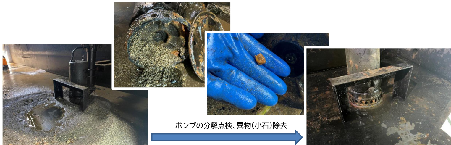
逆洗排水移送ポンプとその周辺の状況 (過負荷発生時)
