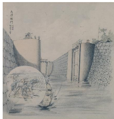
「大津閘門 北国町」
