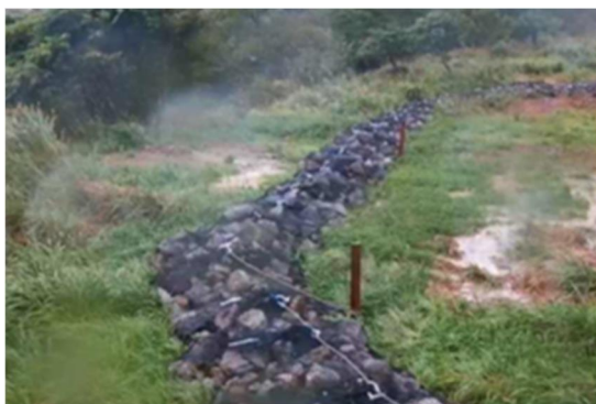
越流水の減勢と分散を図る袋詰玉石の設置(R6. 9)
