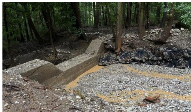
土石流により異常堆積した土砂の浚渫(R6. 9)
