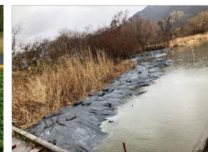
遮光シートの敷設
