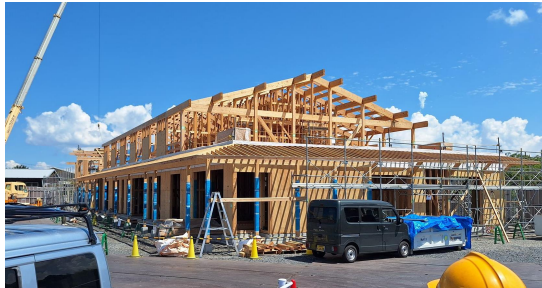
大津市伊香立市民センター大津（建設中）
