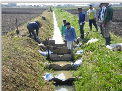
多面的機能支払交付金の活動組織による魚道の設置 (野洲市須原の魚のゆりかご水田にて)
