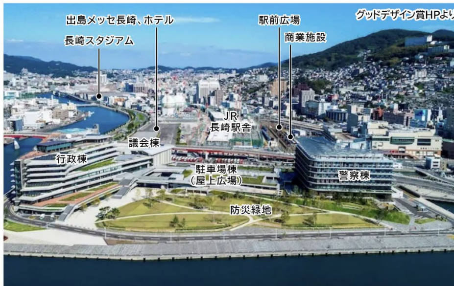
全景:防災拠点となる新庁舎と防災広場を整備
