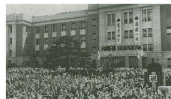
現本館竣工式を祝う旗行列
