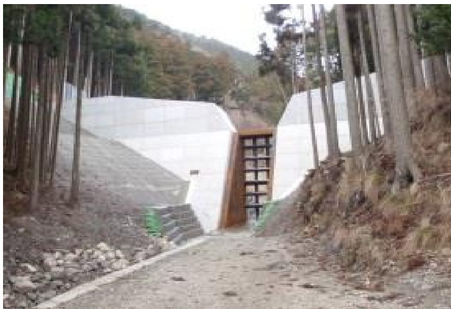
日野谷川堰堤(甲賀市)
