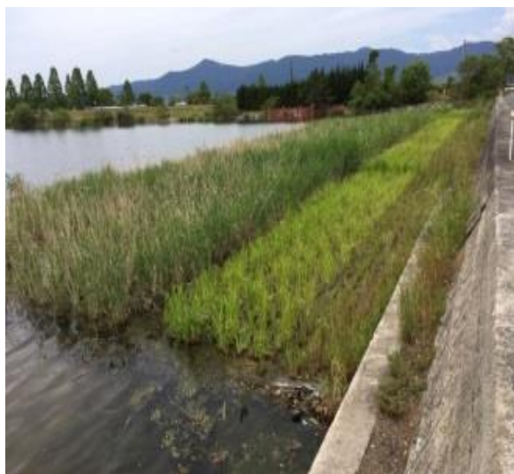
底質改善対策(覆土工・植生工)
