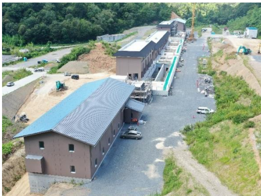
東北部浄化センター(令和7年10月増設完了予定)
