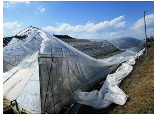
294 台風による農業用ビニルハウスの倒壊 (2018年9月の台風21号)
