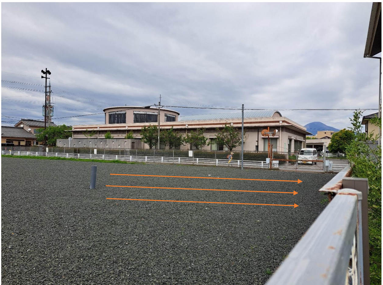
⑲地中埋設管／井戸湧水のオーバーフロー管1本(中央) 透水管2本(両脇)
