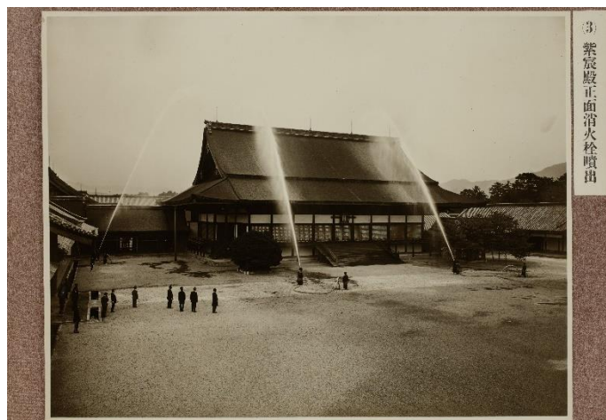
4-5「御所水道写真帖／(3) 紫宸殿正面消火栓噴出」 大正元年（京都市上下水道局・田邊家資料）
