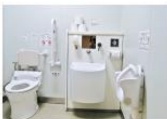
バリアフリートイレ(屋内)
