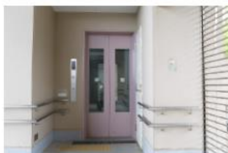
陸上競技場のエレベーター
