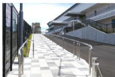
傾斜のある歩道
