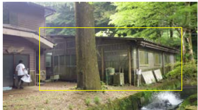
修繕対象施設③ 種苗生産生育施設C棟
