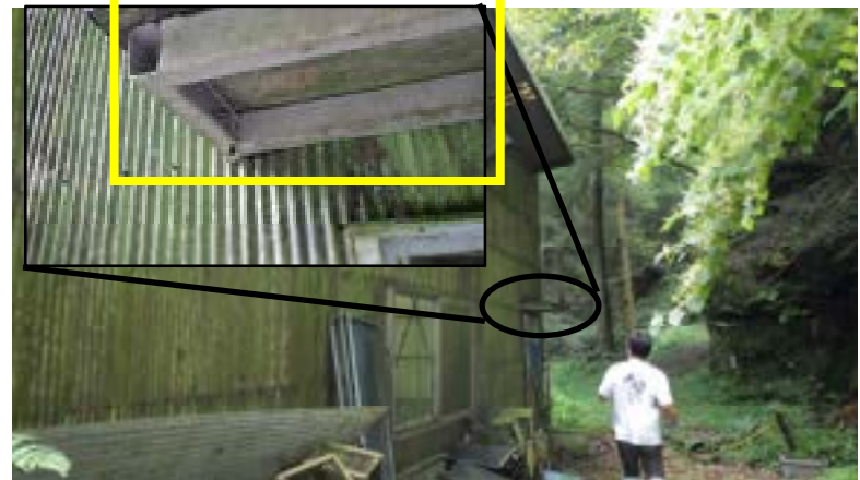
修繕対象施設① A 棟/ウ 北面西端の庇の補修
