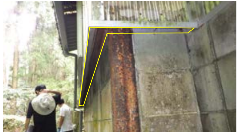
修繕対象施設① A 棟/ア 南面窓枠下部の補修
