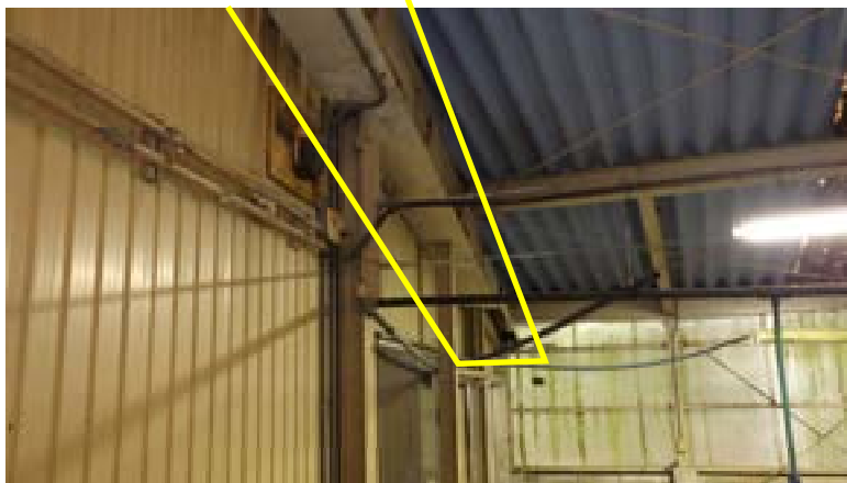
修繕対象施設① A 棟/イ 東面軒天の補修
