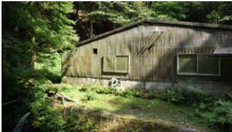
修繕対象施設② 種苗生産生育施設B棟
