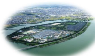
更新工事実施している 湖南中部浄化センター
