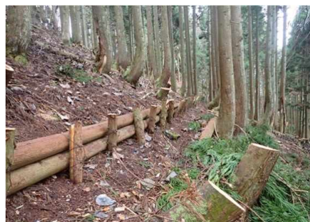
保安林整備：本数調整伐・筋工 (高島市荒谷山国有林)
