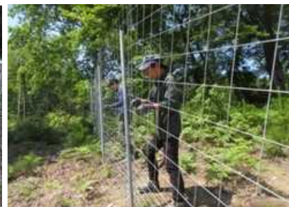
植樹のための獣害柵設置 （森の恵み活用促進事業）
