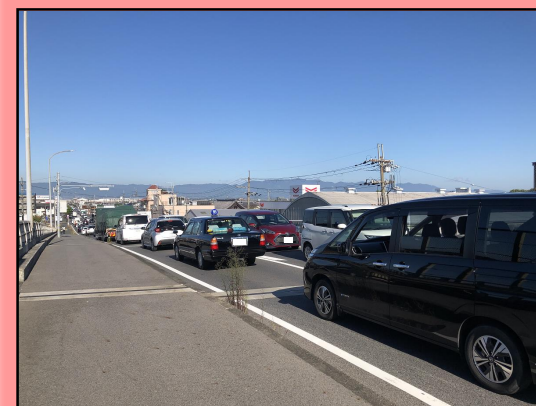
③千代跨線橋 付近
