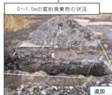
写真-3.2.3 各試掘箇所への掘削状況
