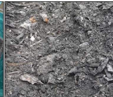
① 廃棄物土掘削工
