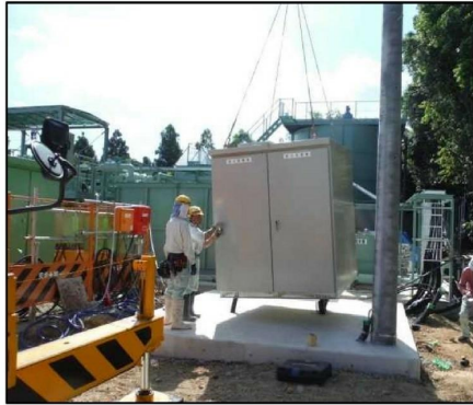
④浸透水処理施設工
