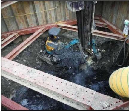
①有害物掘削除去工
