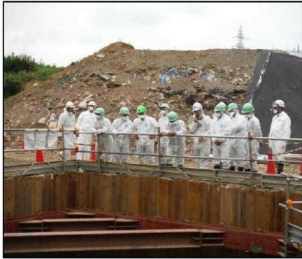
①有害物掘削除去工
