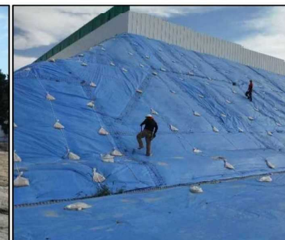
④仮設備工
