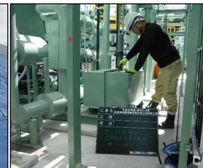
⑤浸透水処理施設工
