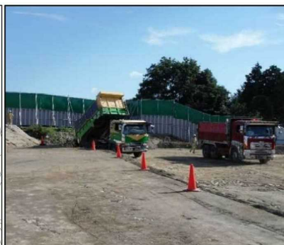
①有害物掘削除去工
