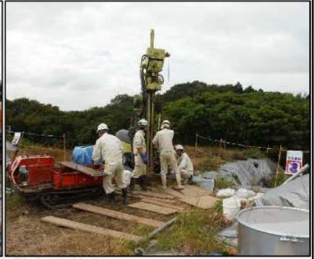
②底面遮水工
