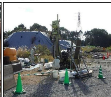
② 底面遮水工
