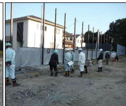
③ 鉛直遮水壁工
