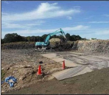
① 廃棄物土掘削工
