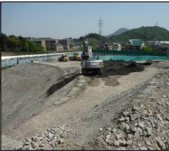
②-2 A工区仮置
