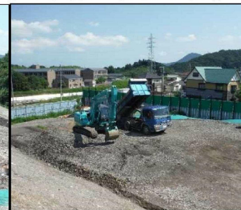
②-2 A工区仮置
