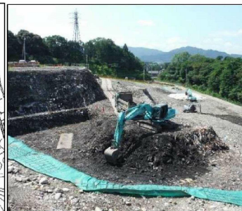
①-1 D・E工区、H区画掘削
