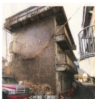
外壁、手すりが崩落した事例
