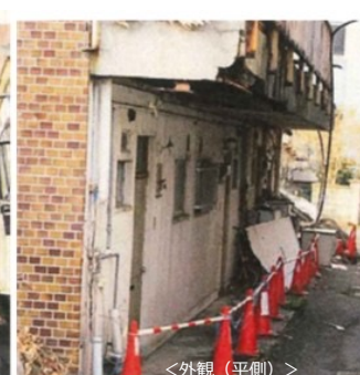
外壁、手すりが崩落した事例
