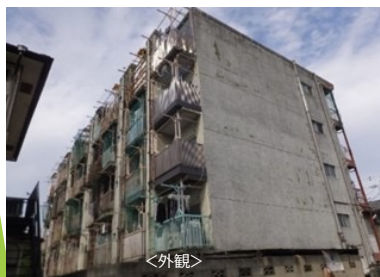
建物の傷みが著しく外壁の剥落、鉄骨の露出などが見られる事例
