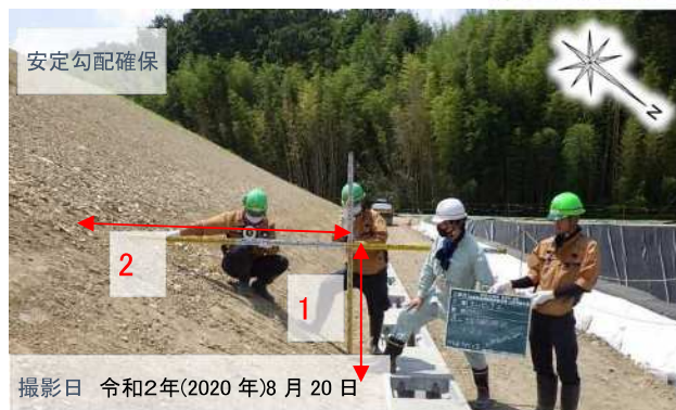
図 4-2-20 キャッピング工施工状況
