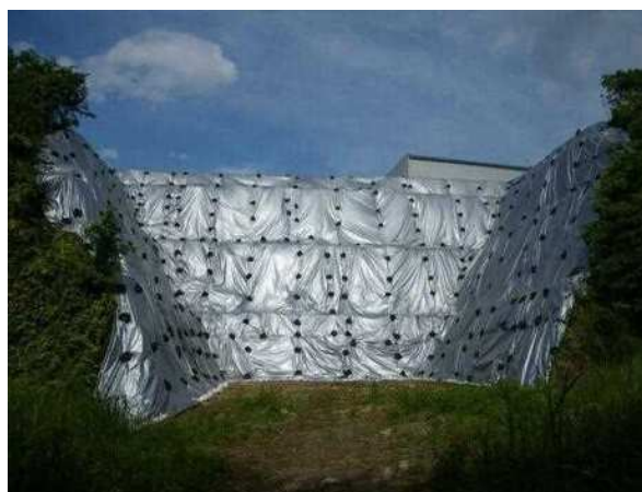
仮設シート（西市道側法面部） 張り替え後
