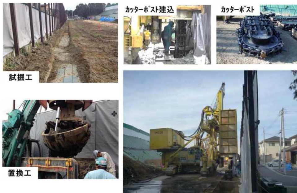
図 4-2-4 鉛直遮水壁の施工状況
