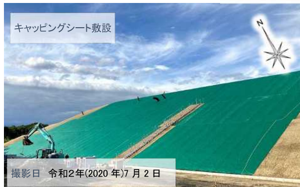
図 4-2-20 キャッピング工施工状況
