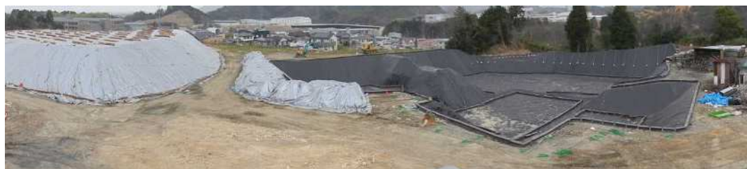
図 3-2-1 有害物等の掘削除去の状況
