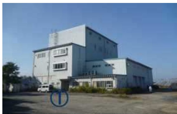
① ガス化溶融炉建屋
