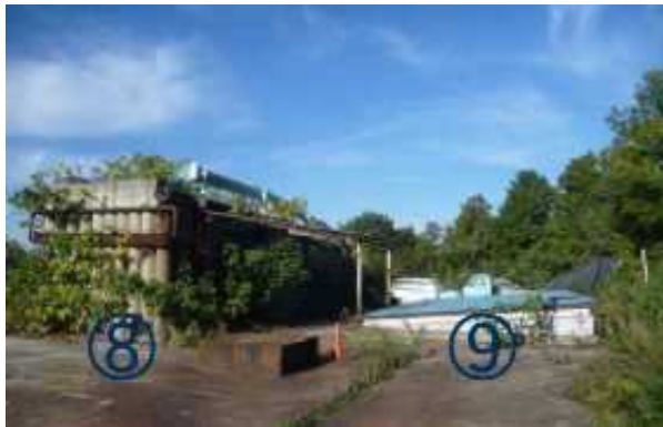
⑧～⑨ 焼却炉スロープ 等
