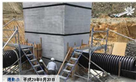
図 4-2-16 揚水ピットの構造
