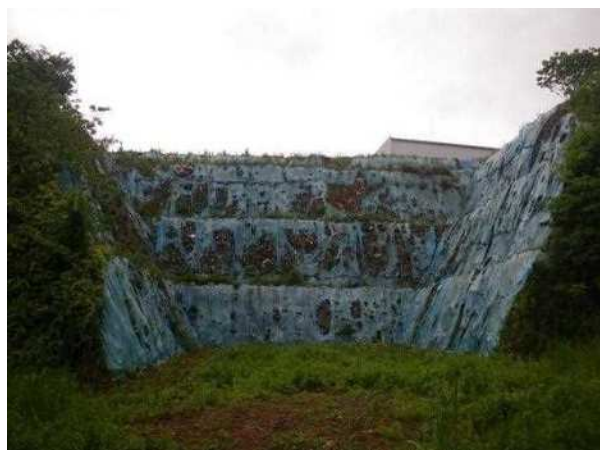
仮設シート（西市道側法面部） 張り替え前
