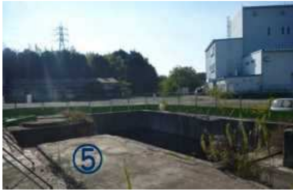
⑤ 南側焼却炉基礎
