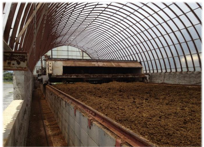
発酵堆肥化施設
