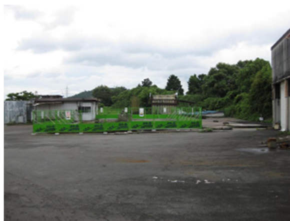
南側焼却炉解体撤去後
