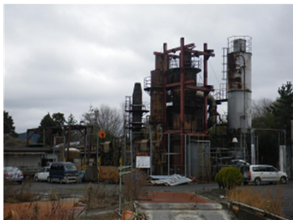
南側焼却炉解体撤去前
