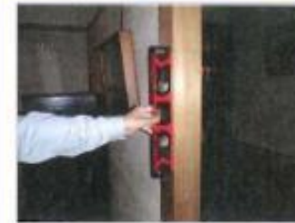
水平器による柱の傾きの計測
