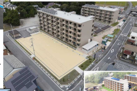
完成写真 (ドローンによる空撮)
