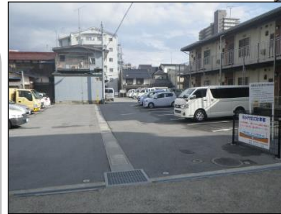
写真：雨水貯留式公用車駐車場（彦根市） ※駐車場に降った雨を一旦柵で貯め、降雨ピークをずらして放流。
