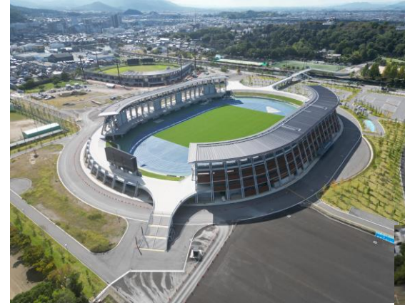
写真：彦根総合スポーツ公園 ※芝生舗装による雨水浸透対策 雨水貯留槽を整備し、芝生等への散水等利活用。
