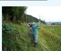
鳥獣害防護柵の補修・設置
