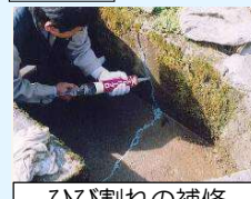
ひび割れの補修
