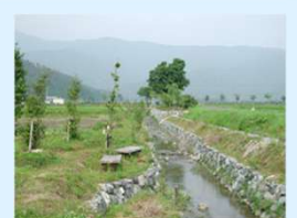
石積水路の設置
