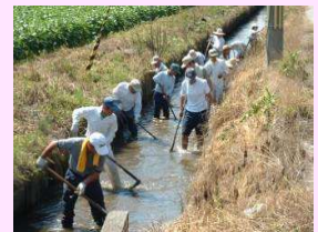
水路の泥上げ
