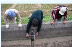
施設の機能診断
