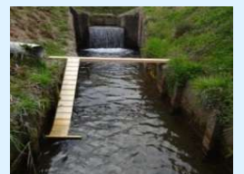
水路からの脱出施設の設置
