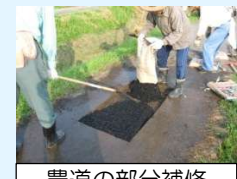
農道の部分補修
