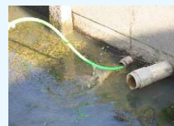
暗渠施設の清掃
