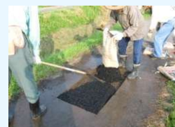
農道の部分補修
