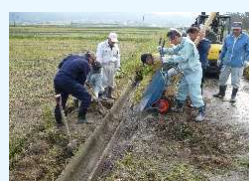
水路法面の初期補修
