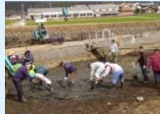
浄化池の泥上げ
