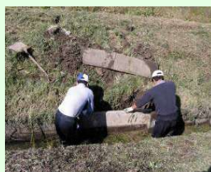
排水路の補修
