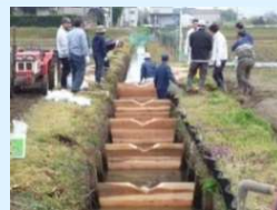
水路魚道の設置(堰式)
