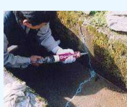
水路のひび割れ補修
