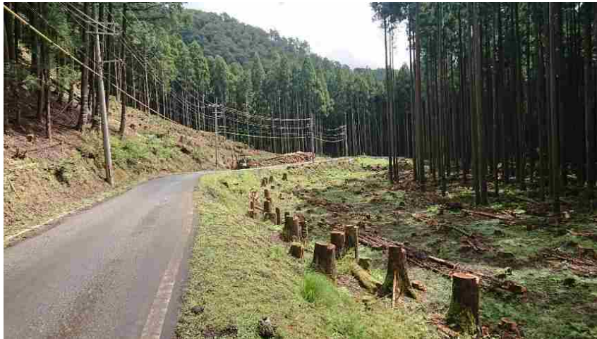
道路沿いの予防伐採を行った現場
