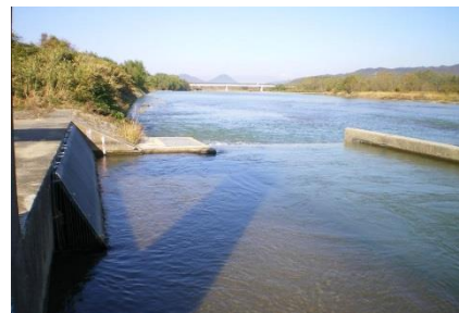
水口浄水場取水口（野洲川）
