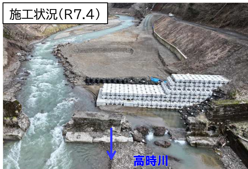
左岸側ブロック施工完了(R6.12)
