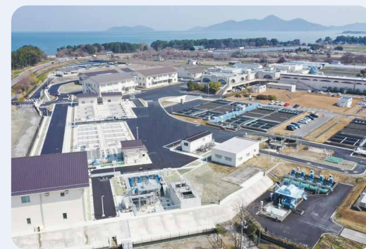
竣工した吉川3系浄水施設
