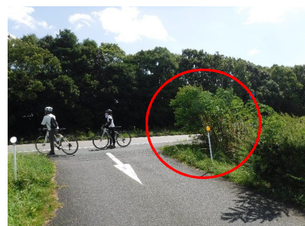
植栽による視距不良（車両進入口等）
