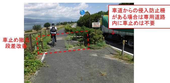
不要な車止めの除去 （進入口に車止めがあり、不要と考えられるもの）
