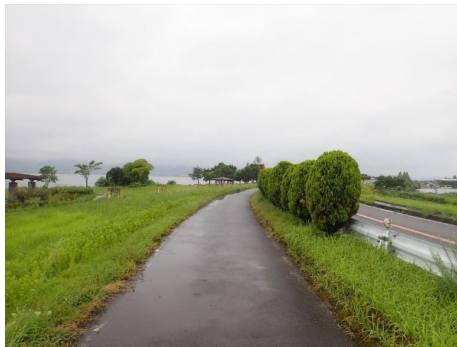
植栽帯による視距不良
