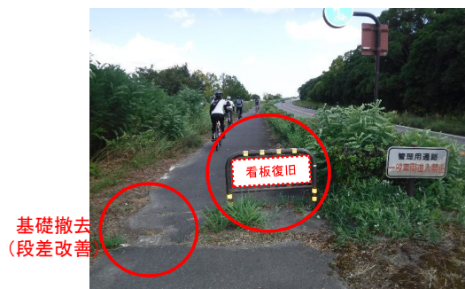
車止め（看板復旧、基礎撤去（段差改善）
