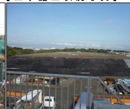
② 選別土仮置き・盛土工
